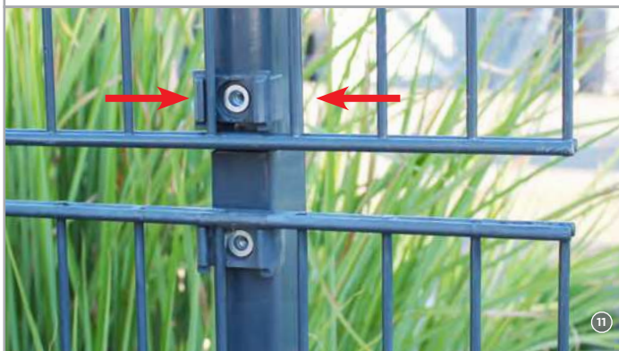
Abb. 3 Gittermatte an der Verlängerung anbringen!
