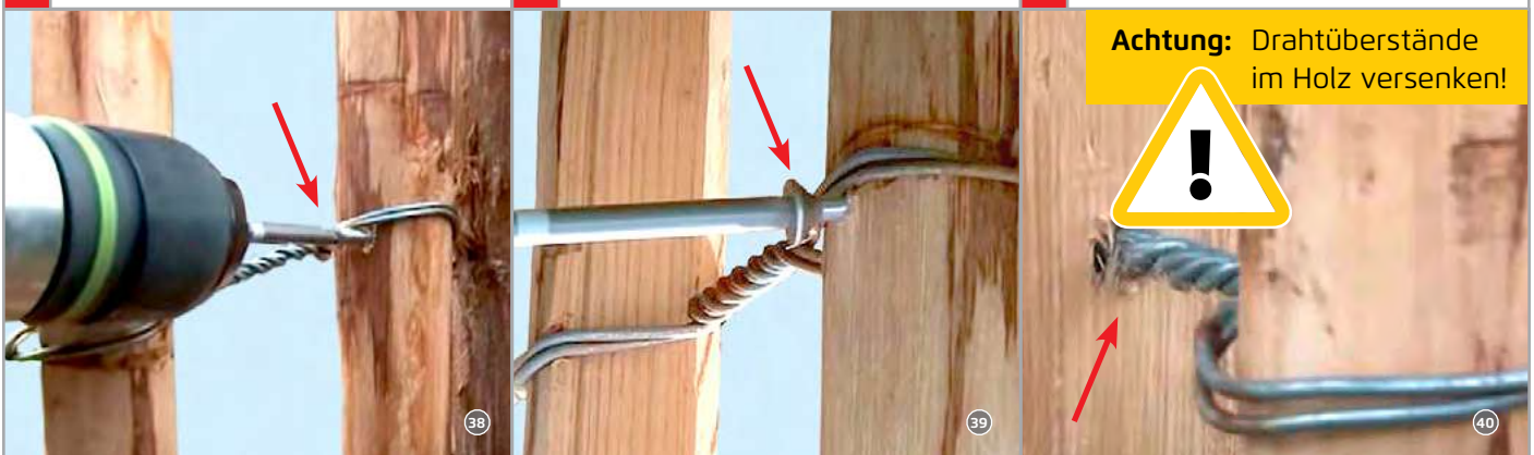
19 Loch in Pfosten und Stakete bohren!
