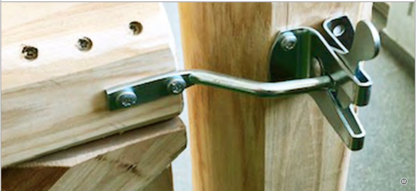
Abb. 19 Torriegel befestigen!
