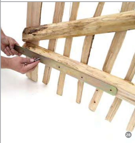
Abb. 16 Ausmessen der Befestigungslöcher!
