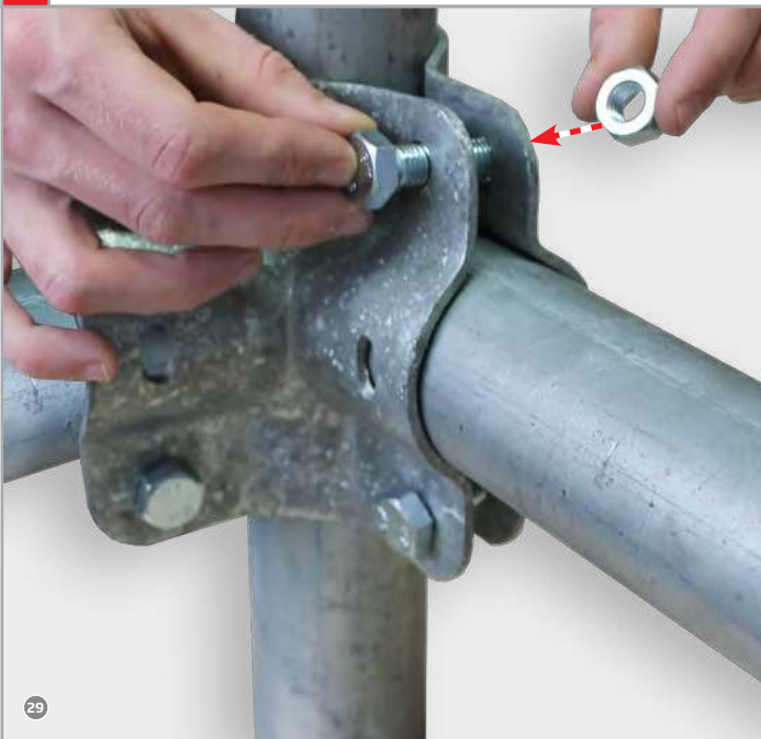
15 Sechskantschrauben mit Muttern festdrehen!
