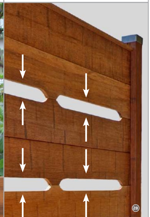
Abb. 13 Dekorset mit Ausklinkungen im Brett!
