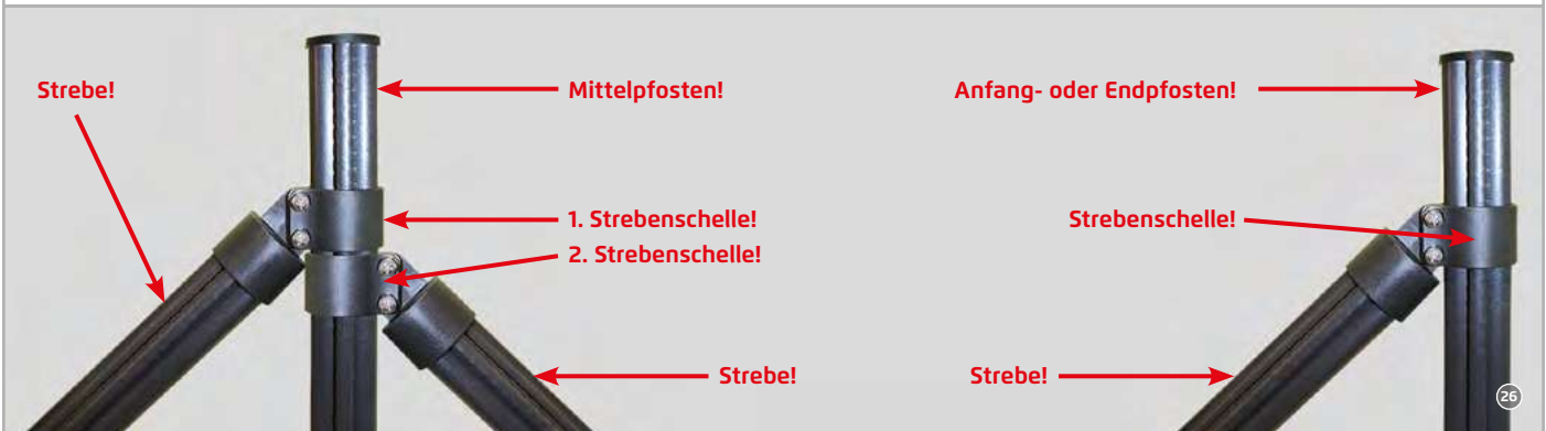
Abb. 16 Die doppelte Verstrebung in der Mitte stabilisiert die Zaunanlage!
