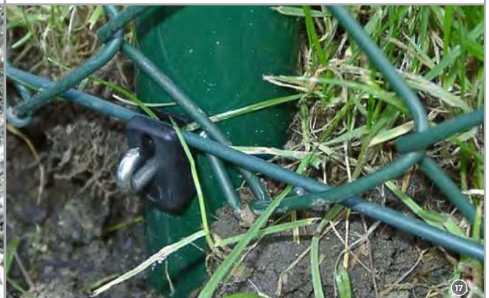
Abb. 5 Spanndrahthalter dicht über der Grasnabe!
