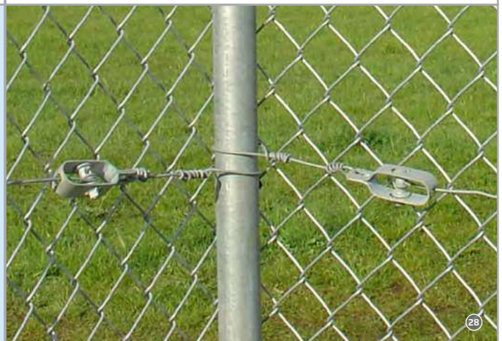
Abb. 15 Am Mittelpfosten wird ohne Wellstab abgespannt!
