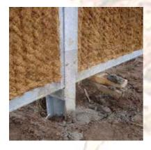
Nachdem aushärten des Betons, werden die Elemente mittig von oben zwischen den Flanschen der Pfosten eingelassen. Damit Sie an dieser Stelle der Montage keine Probleme bekommen, ist es sehr wichtig den Pfostenachsabstand beim betonieren exakt einzuhalten. Um die eingefädelten Elemente zu fixieren befestigen Sie diese mit den ersten zwei selbst schneidenden Schrauben.
