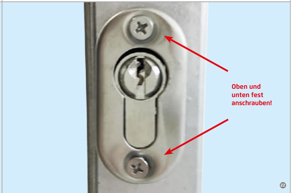
Abb. 10 Zylinder mit montierter Ovalrosette!
