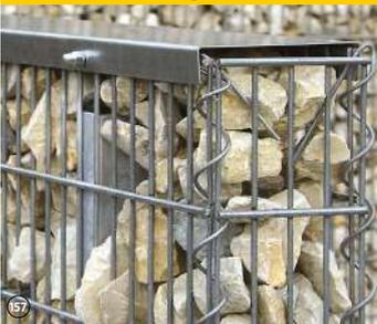
Das U-Profil als Abdeckung für Mauersysteme hat eine Gesamtlänge von 2000 mm.
