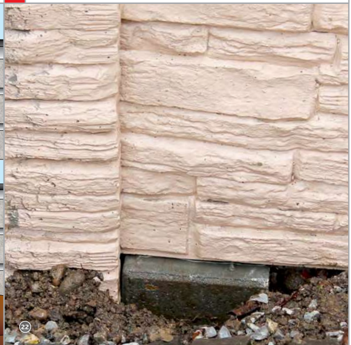
6 Die Platte mit Erde unterfüllen und den Unterbau verdichten!
